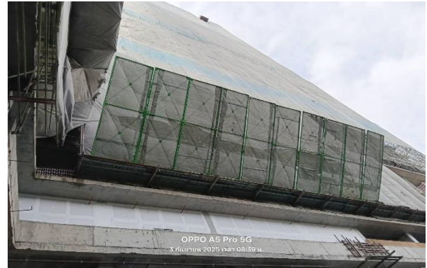
รูปที่ ก-55 การติดตั้งแผงป้องกันฝุ่น และของตกหล่นขณะทำงาน
