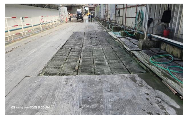
รูปที่ ก-27 ท่อระบายน้ำและบ่อดักตะกอนดิน
