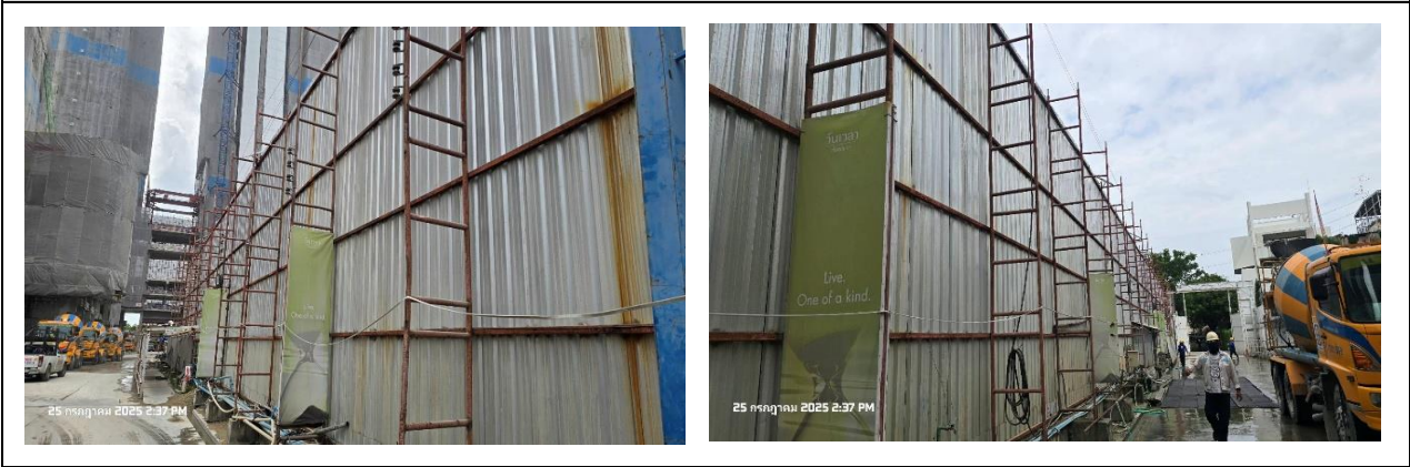
รูปที่ ก-3 รั้ว Metal Sheet สูง 6 เมตร โค้ชขอบบริเวณพื้นที่ก่อสร้าง
