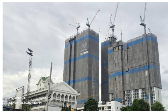
รูปที่ ก-56 ควบคุมการกวาดแขน (Boom) ของเครน ให้อยู่ในภายในพื้นที่โครงการ
