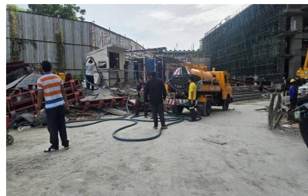
รูปที่ ก-25 มีการสูบน้ำตะกอนส่วนเกิน จากระบบบำบัดน้ำเสียไปกำจัด
