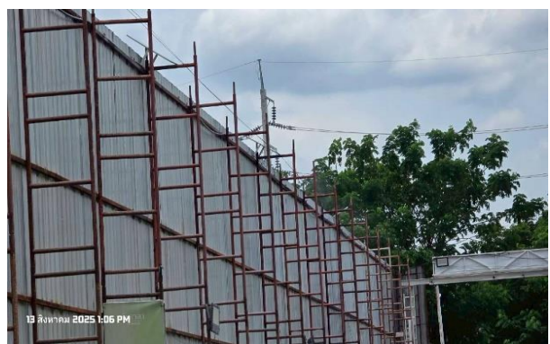
รูปที่ ก-14 ม่านละอองน้ำบริเวณรั้ว Metal Sheet รอบโครงการ
