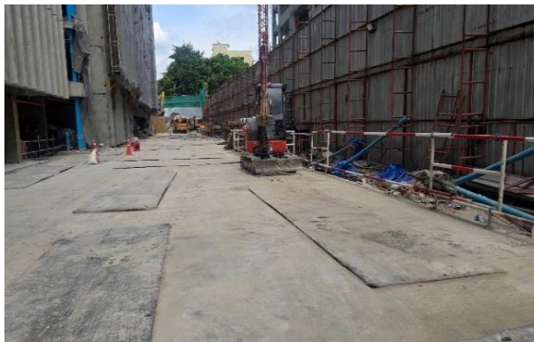
รูปที่ ก-16 แผ่นเหล็กอย่างหนา ปูบริเวณภายในพื้นที่โครงการ
